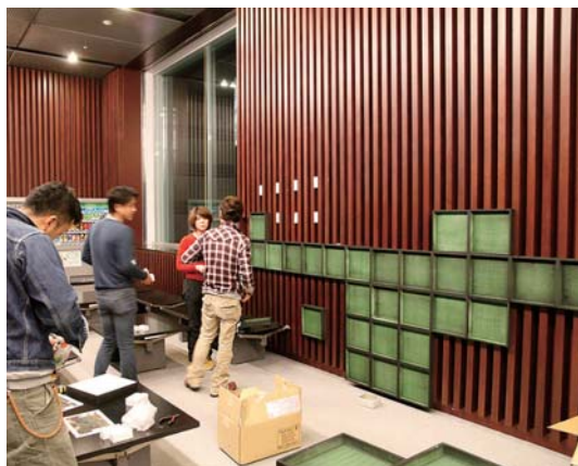
②壁にマットを取り付けるためのフレームを配置。
